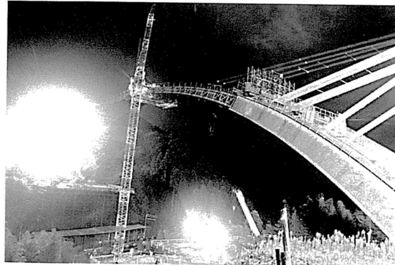
メラン閉合状況 (H12.9)
