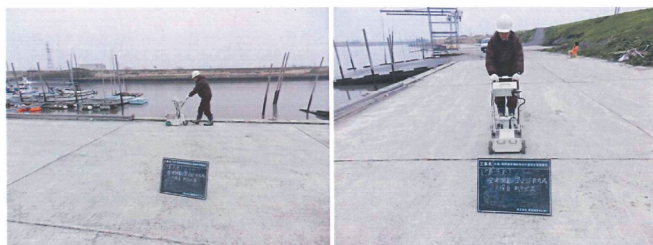
図-2.1 地中レーダ探査の作業状況図
