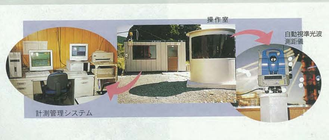
■写真5—自動計測管理システム
