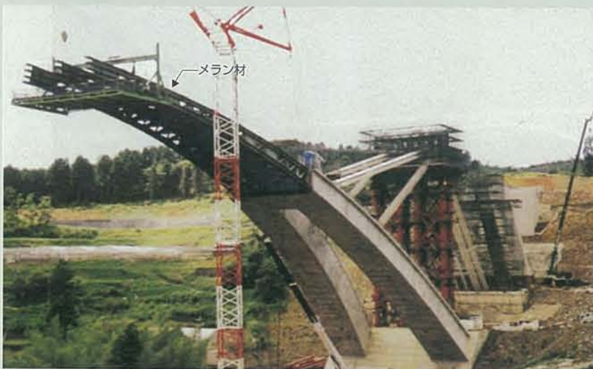
■写真4—メラン材架設状況
