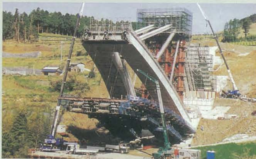
■写真3—吊り支保工による施工完了、撤去
