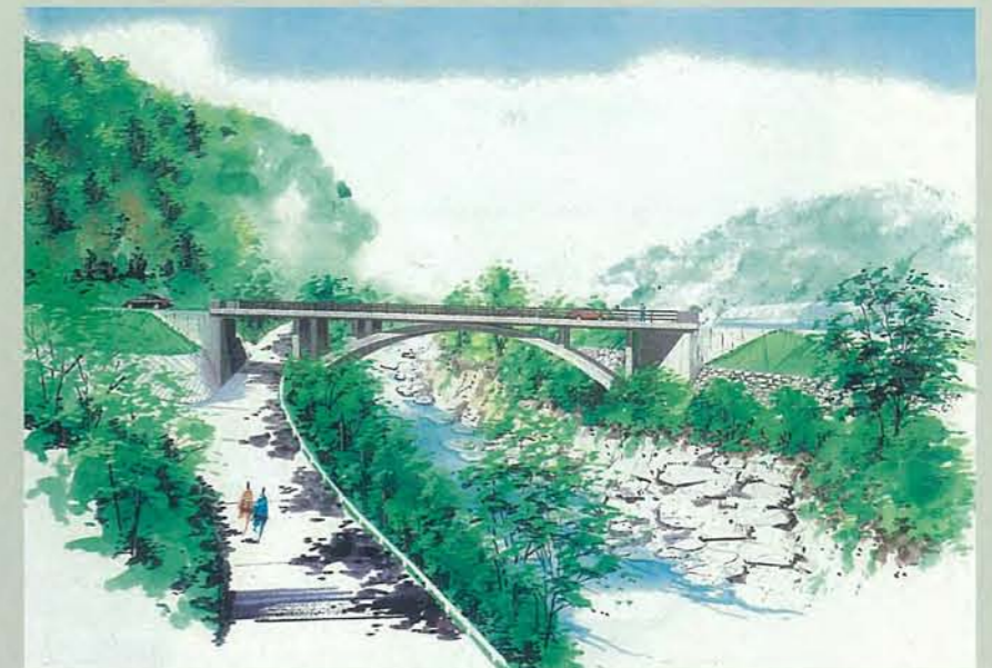
RCコンクリートアーチ橋
