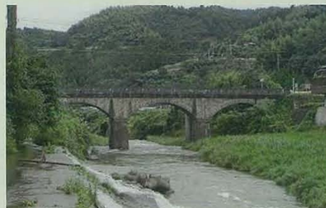
三連の大瀬橋(大正6年竣工)「み」
