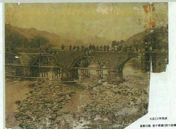
■写真3—当時の石橋の架設風景（大正11年）
