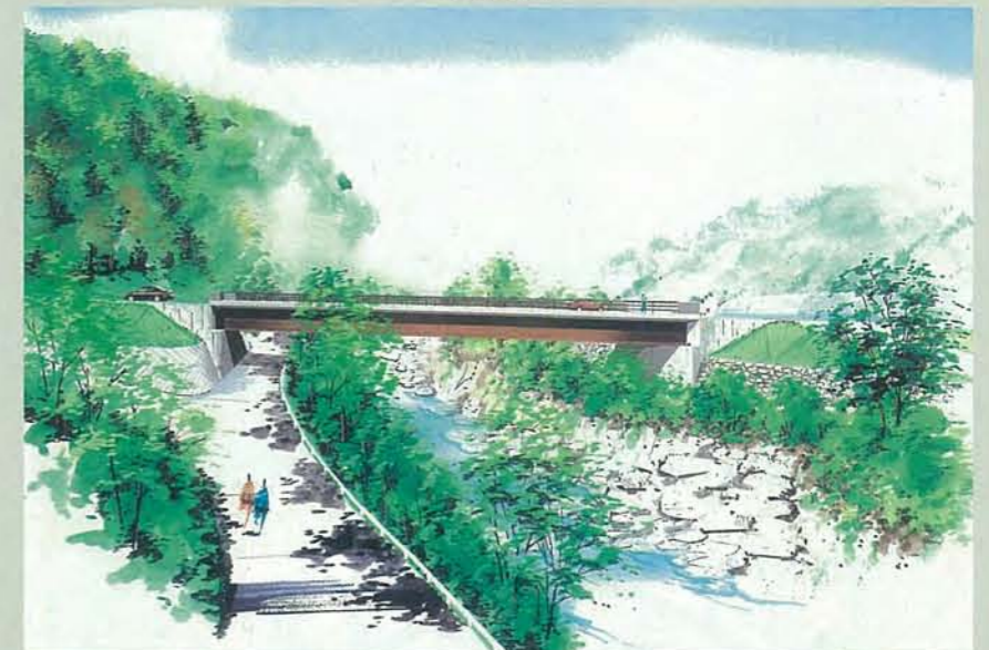
鋼単純非合成I桁橋
