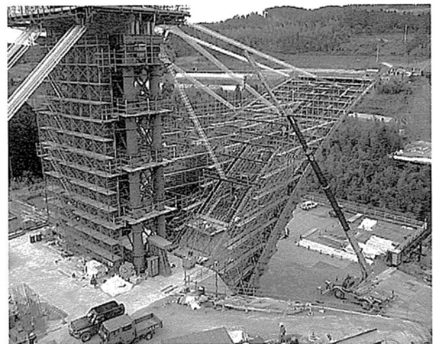
写真-3 吊り支保工の施工
