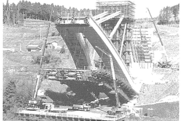
写真 - 5 吊り支保工解体状況
