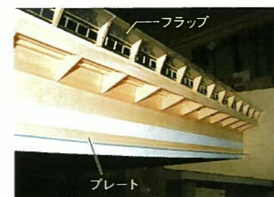
写真1 耐風対策構造細部拡大
