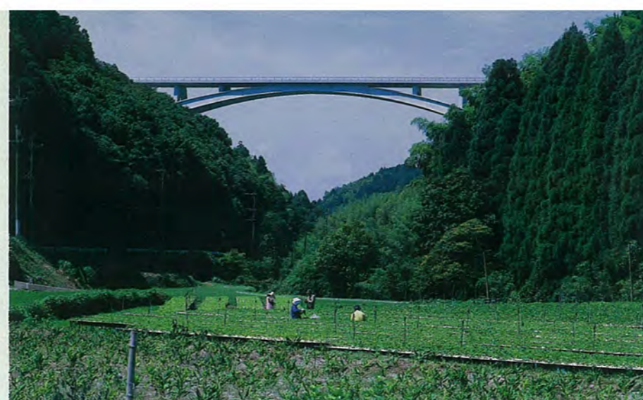
アーチリブの上下端の張り出し部分が側面に陰影を描き出す。谷底から70mの高さに架かる。周辺は棚田や茶畑の広がる典型的な山間地
