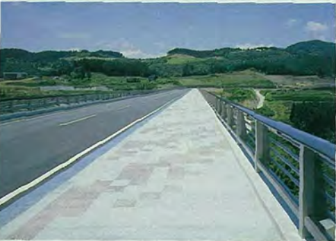
自然石を張った歩道は幅員が3.5mある。高欄の笠木に照明が埋め込まれている
