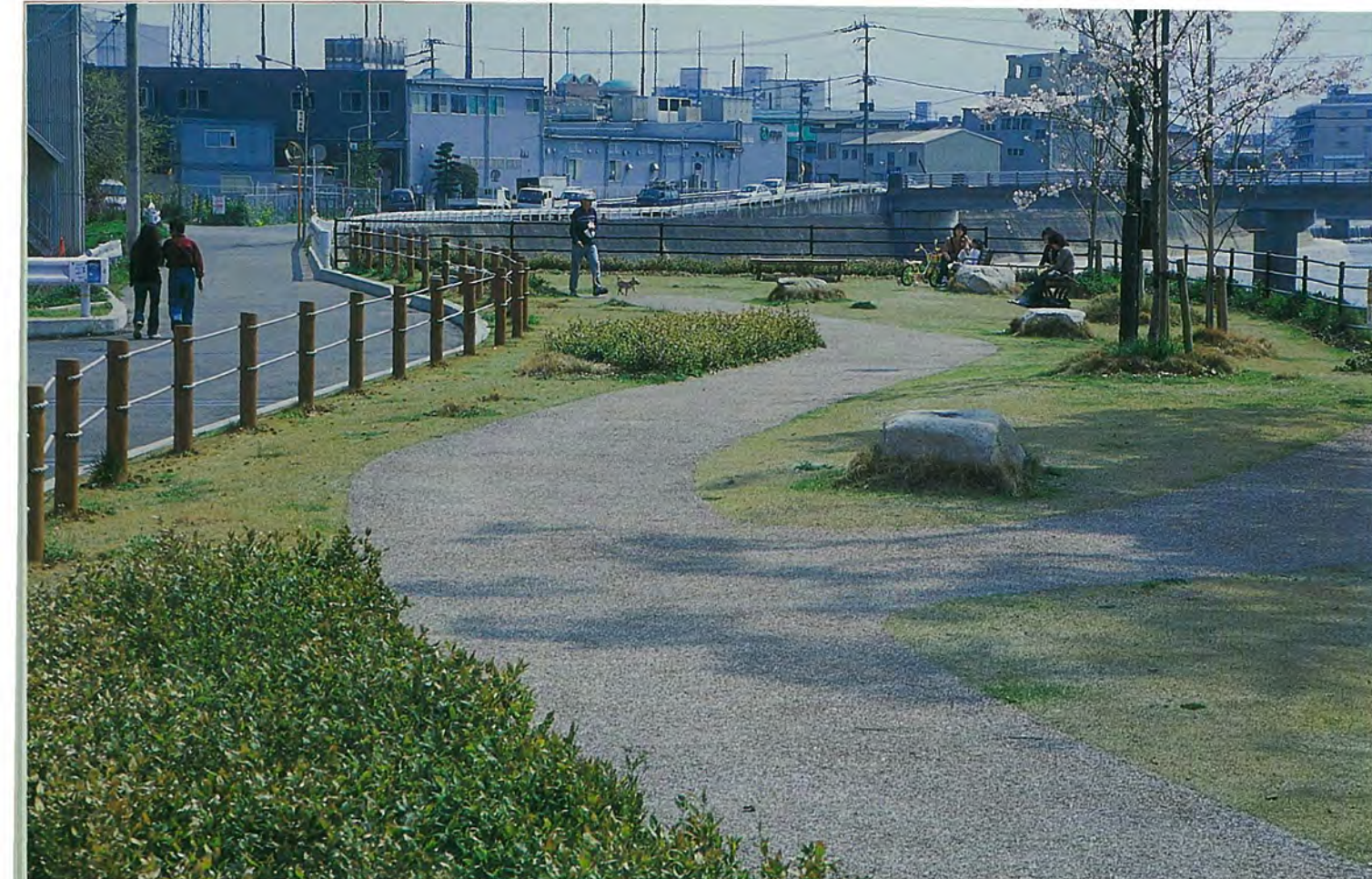
緑地の風景。この下を分水路が通っている。維持管理用の10tトラックが乗り入れられるように床板を設計してある
