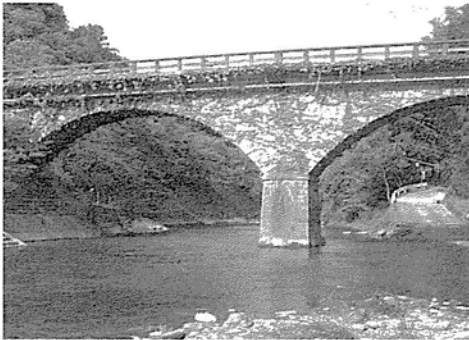
寄口橋(二連アーチ橋・大正9年竣工)
