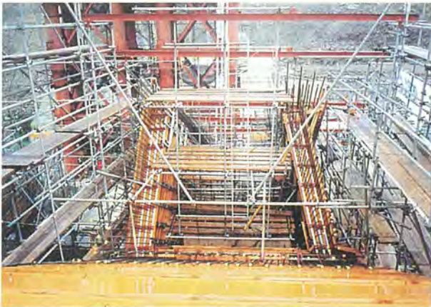
写真-2 アーチリブ施工状況
