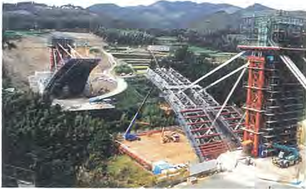
写真-1 吊り支保工施工状況
