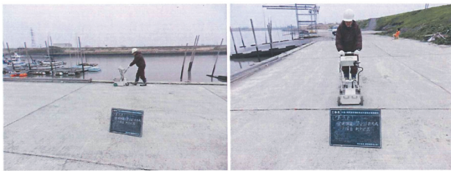
図-2.1 地中レーダ探査の作業状況図
