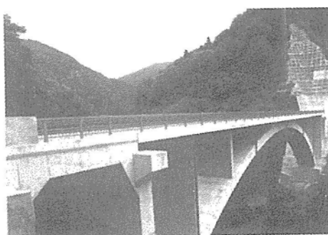
アーチリブ：拡幅なし 鉛直材：壁式
